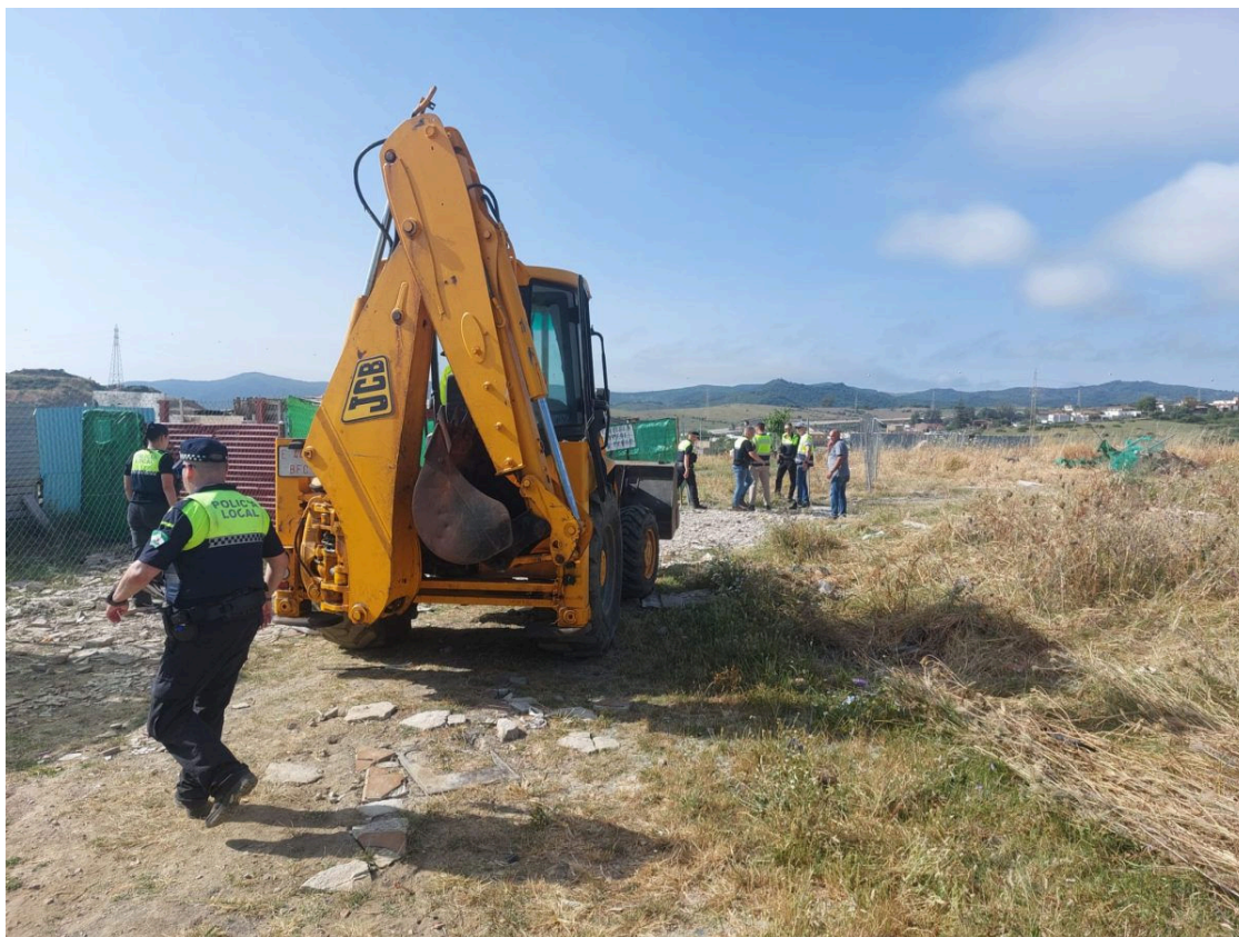
Maquinaria utilizada para el derribo en Los Pastores.
