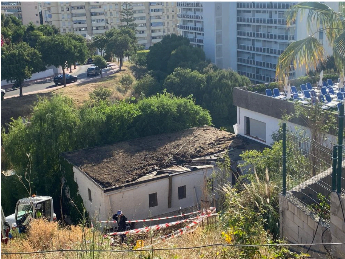
Obras de reparación de la rotura de la tubería en la zona de Los Patos, Benalmádena/E. Castillejo
